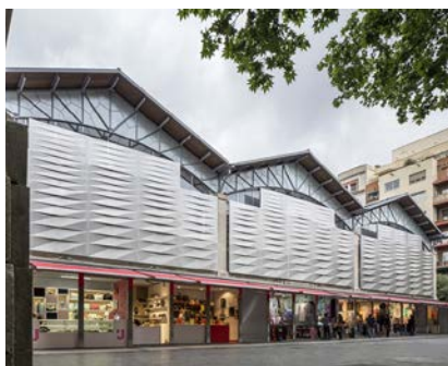
Remodelação do mercado "El ninot" Barcelona (Espanha)
