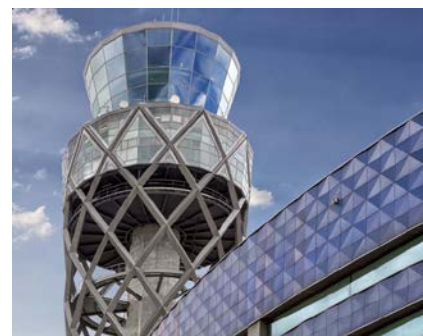
Torre de Controlo do Aeroporto de Bogotá (Colombia)
